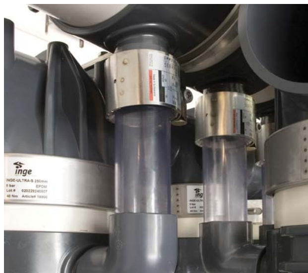
Монтаж смотровых стёкол при помощи муфт GRIP-L
