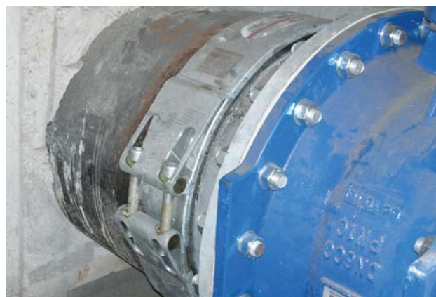
Компенсация разности диаметров при установке запорно-регулирующей арматуры
