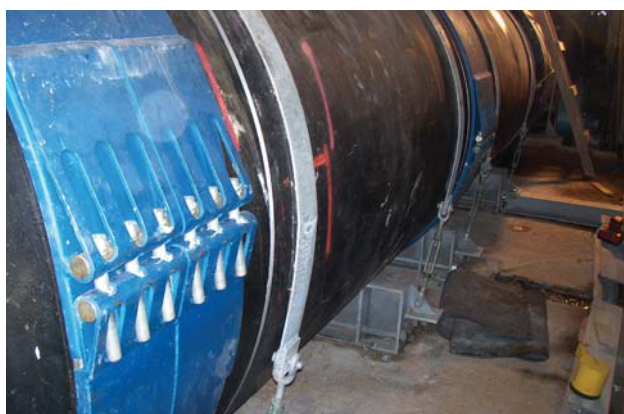
STRAUB-FLEX используется как компенсатор на нестабильных почвах
