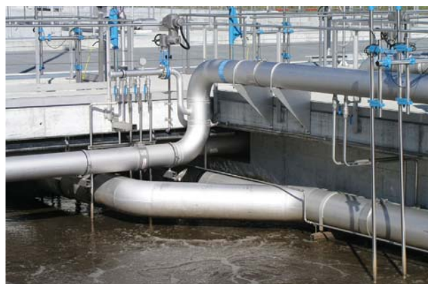
Предварительно подготовленные секции смонтированы с помощью STRAUB-GRIP-L
