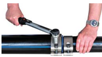
Затяните болты динамометрическим ключом
