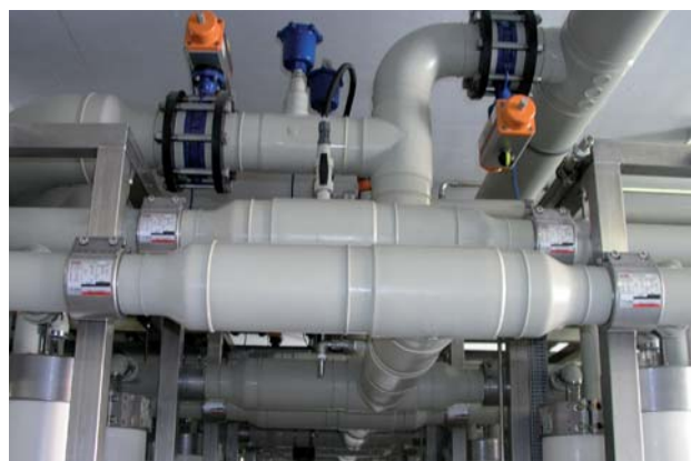
Установка на станции водоочистки
