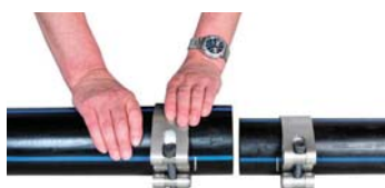
Установите внешние хомуты на трубу
