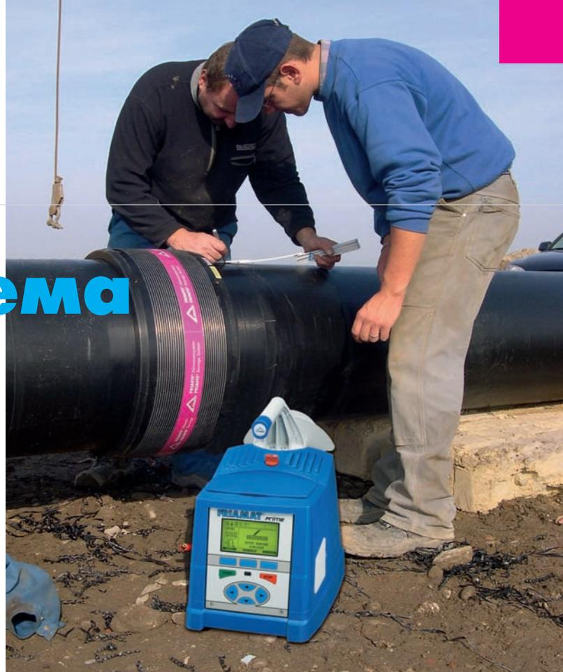
**Соединительные технологии, которые действительно имеют преимущество: терморезисторная сварка**
