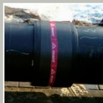
Муфты FRIAFIT (AM), SDR 17 обеспечивают надежное сварочное соединение труб из ПЭ-ВП для всех диаметров. Дополнительной надежностью для диаметров свыше d 560 является зарекомендовавшая себя много раз на практике техника предварительного прогрева.
